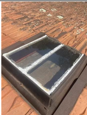
Photo n° PhA004 Localisation : Toiture - Fenêtre 2 Ouvrage : 1 - Couvertures, Toitures, Terrasses et étanchéités - Fenêtres de toit, lanternaux, verrières Partie d'ouvrage : Mastic (vitriers, bitumineux...) Description : Mastic vitrier dur blanc sur fenêtre de toit
