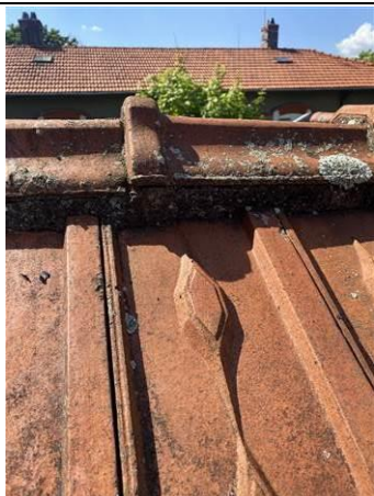
Photo n° PhA005 Localisation : Toiture - Toiture Ouvrage : 1 - Couvertures, Toitures, Terrasses et étanchéités Partie d'ouvrage : Faîtage Description : Joint de scellement de tuile faîtière
