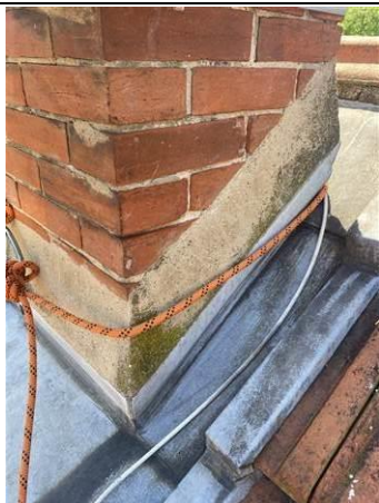
Photo n° PhA007 Localisation : Toiture - Cheminée Ouvrage : 1 - Couvertures, Toitures, Terrasses et étanchéités - Éléments associés à la toiture Partie d'ouvrage : Conduit de cheminée Description : Joint de scellement du solin du conduit de cheminée
