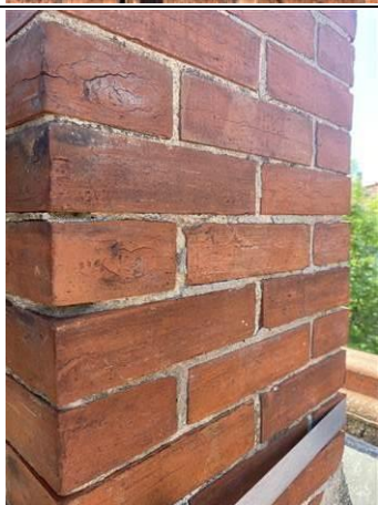
Photo n° PhA006 Localisation : Toiture - Cheminée Ouvrage : 1 - Couvertures, Toitures, Terrasses et étanchéités - Éléments associés à la toiture Partie d'ouvrage : Conduit de cheminée Description : Joint de scellement des briques du conduit de cheminée
